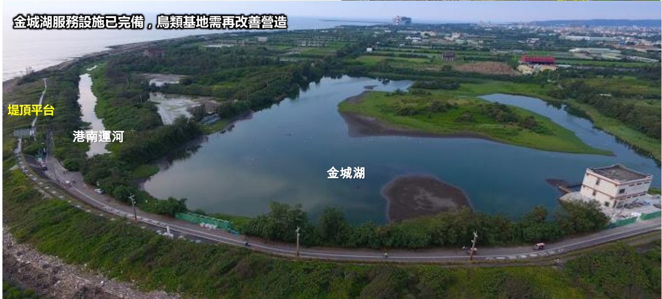
圖表 15 港南運河至金城湖堤頂人行及自行車觀海長廊現況照片
